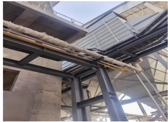
施工管道（图三）
